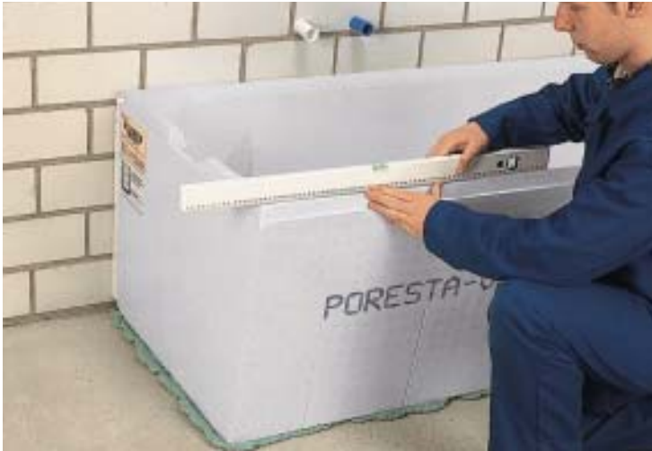
3. Position bath tub support and align. Plaats de badkuip- of douchebakdragers en lijn deze uit.
