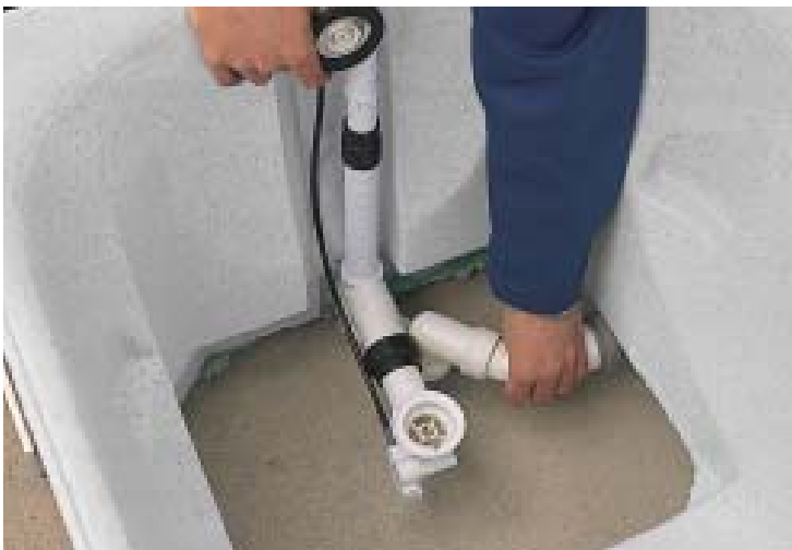
4. Fit drain and overflow fittings. Plaats de afvoer- en overloopgarnituur.
