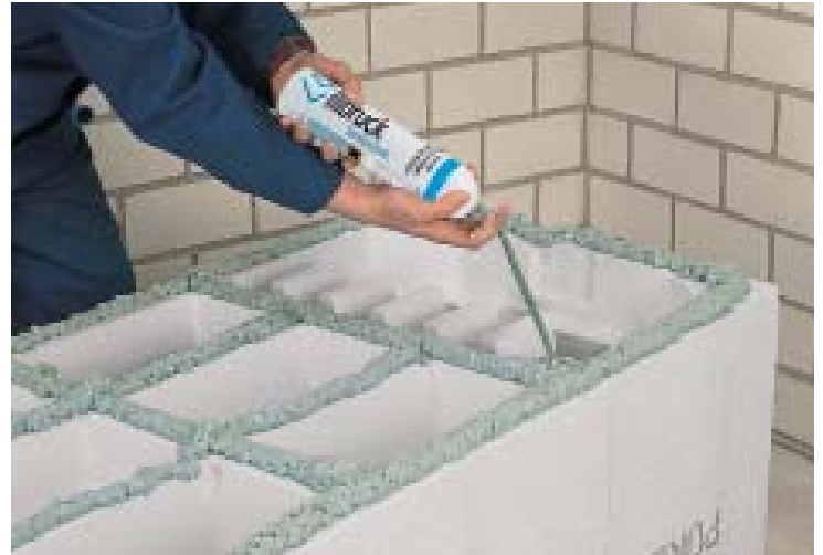
2. Turn support over and fill dividing bars with foam. Draai de dragers om en breng het schuim aan.
