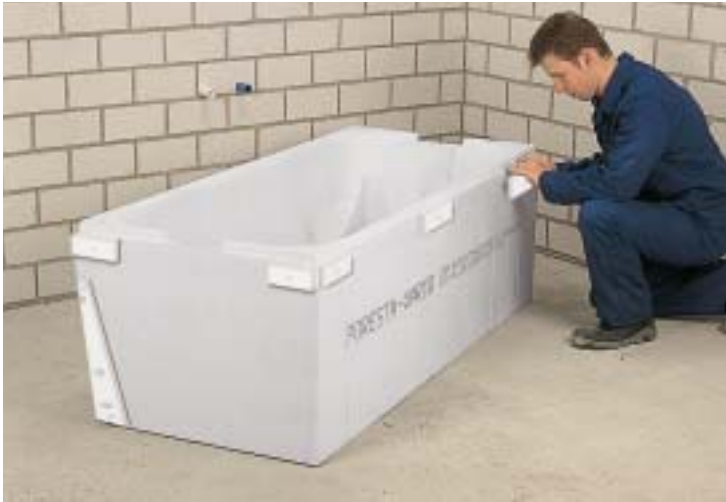
1. Fit wall spacers. Brenge de wandafstandshouder aan.
