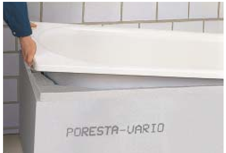
5. Place the tub in the support. Plaats de badkuip of douchebak in de dragers.
